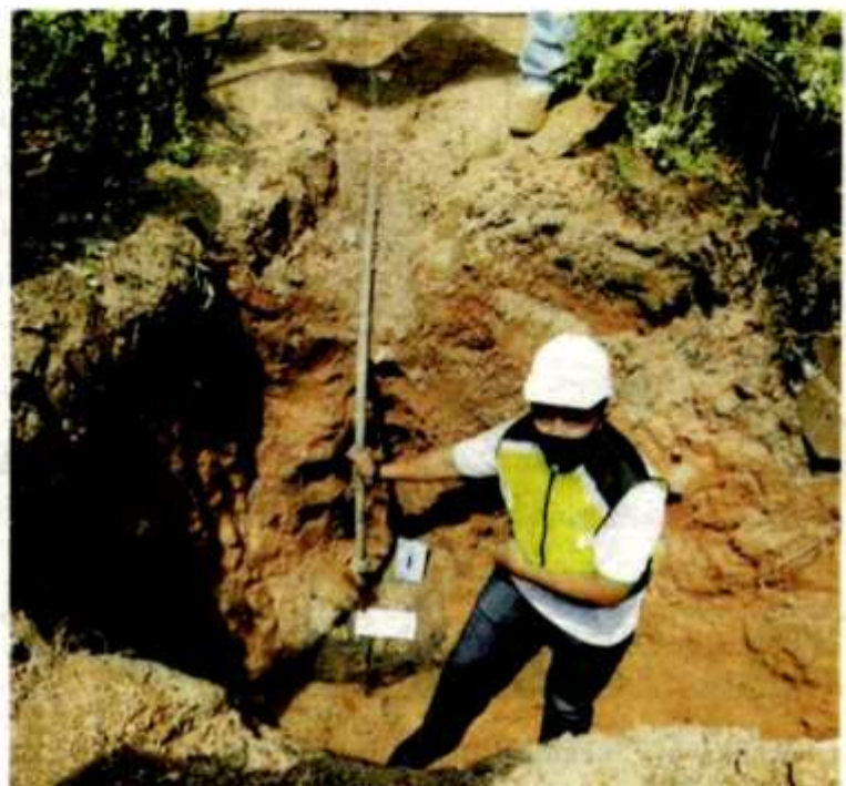
Mohd Fazil menunjukkan sambungan bekalan air secara haram daripada paip utama Air Selangor ke tapak pembinaan itu pada Rabu.
